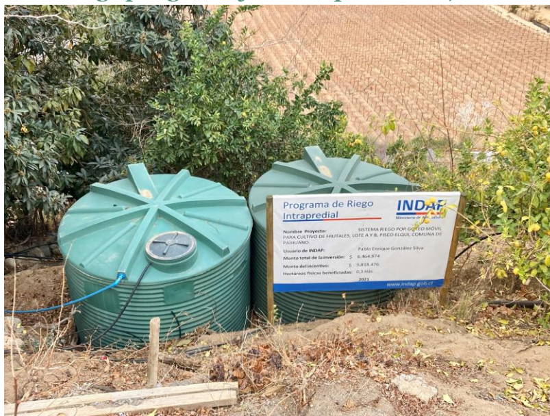
Imagen 2. Sistema de riego por goteo ejecutado por INDAP, Paihuano. Julio 2022.
